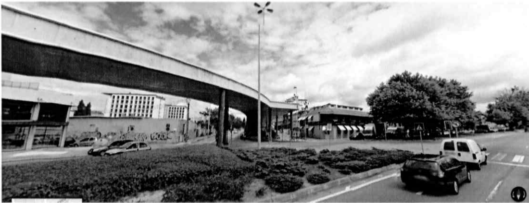
Figura 20: Viaduto de ligação à Av. Fabril do Norte - Amplas superfícies sem utilização e défice de enquadramento paisagístico.
